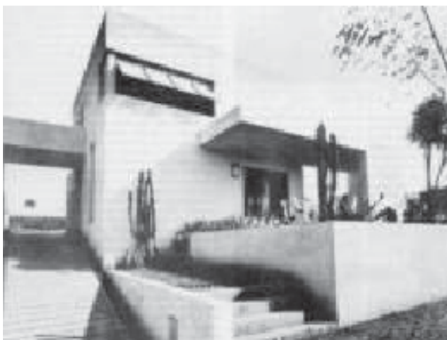
Figura 1. Casa da rua Itápolis (São Paulo) de Warchavchik.
